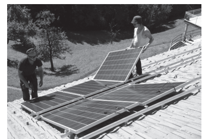
Montage einer privaten Photovoltaikanlage
