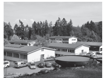
Photovoltaikanlage der Lebenshilfe Batschuns
